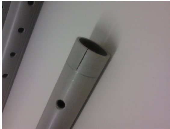
Figuur 6: Een korte snede aan de uiteinden vergemakkelijkt het uit elkaar halen van het frame.
