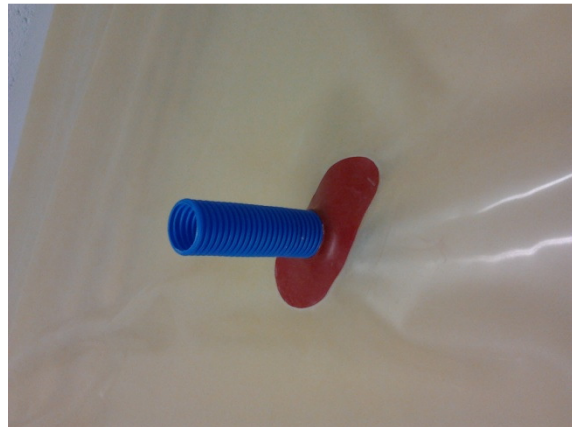
Figuur 10: buis doorheen de ademopening
